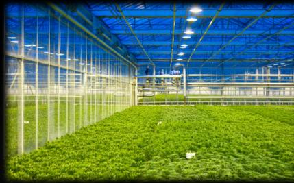
Im Gewächshaus reicht eine Leuchte alle 3 m als zusätzliches Licht aus, um Pflanzen im Wachstumszustand zu halten. Es wird eine 3D-Projektion erstellt, um den Lichtbedarf der Pflanzen zu respektieren.
